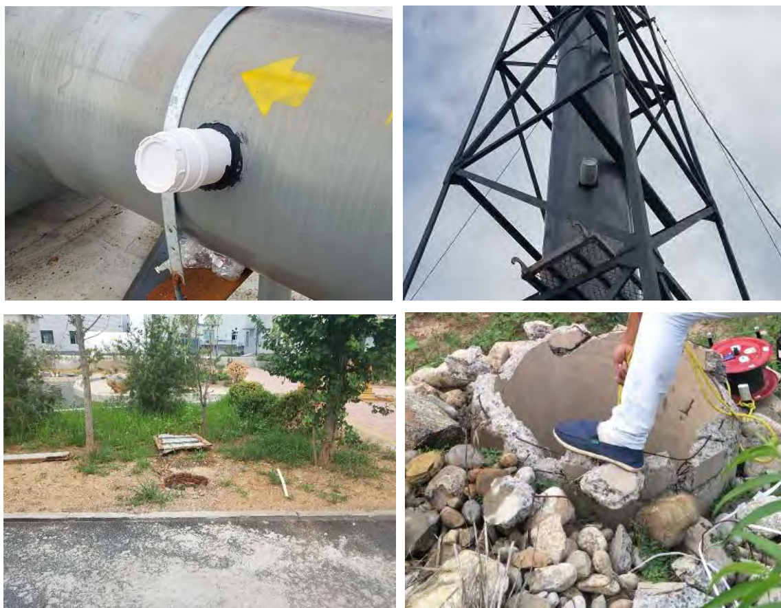
图 4-3 采样口、地下水监控井照片
